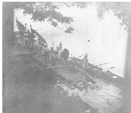
Bild 3 – Aufbruch von Halle
